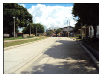
MEJORAMIENTO DE PISTAS
