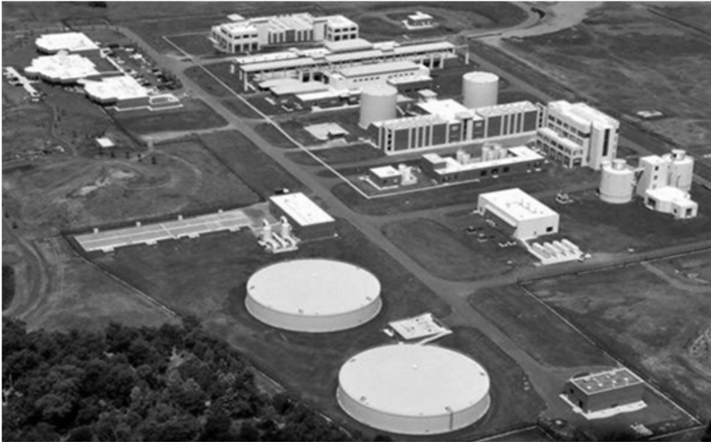
PLANTA DE PROCESAMIENTO DE AGUA POTABLE
