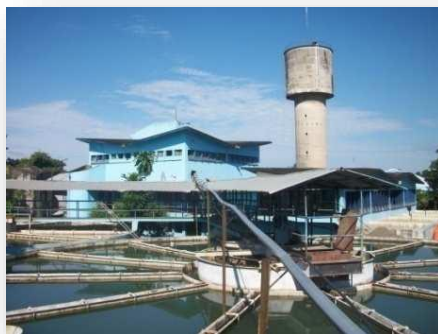
Foto N° 01: Descantador. Foto N° 02: Filtros
