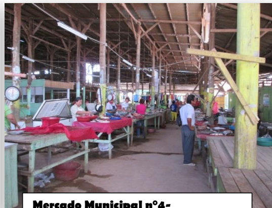
Mercado Municipal n°4 - Infraestructura deteriorada.
